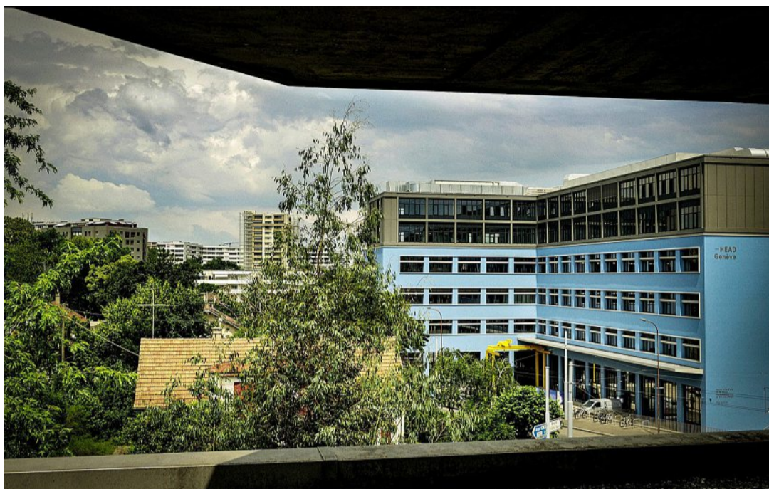
Le nouveau bâtiment de la HEAD vu depuis l'édifice Elna. Devant l'entrée, le jaune de l'ancien pont roulant se détache sur le bleu de la façade. LAURENT GUIRAUD
