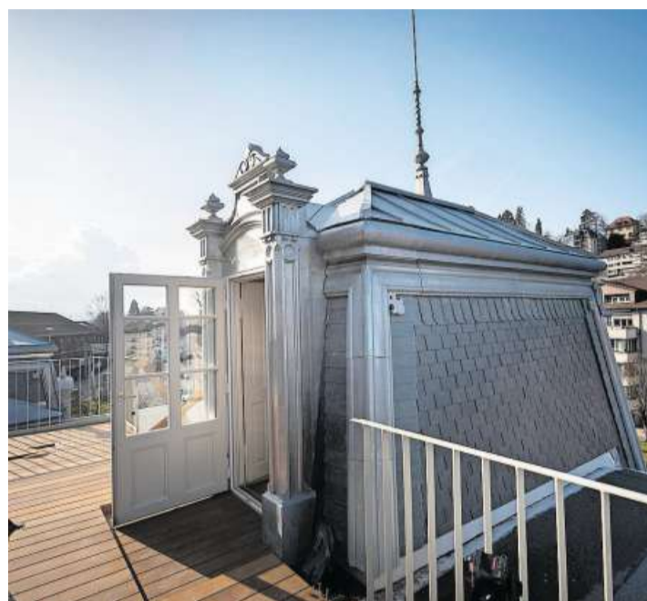
Neues Dach, neue Dachterrasse, rekonstruierte Türmchenaufbauten: Nun fehlt nur noch das alte schmiedeeiserne Geländer.
