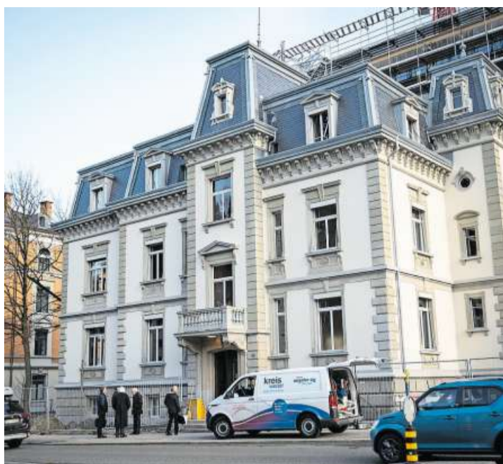
Die Fassade bröckelt nicht mehr: Rund 80 Prozent des Sandsteins mussten bei der Sanierung ersetzt werden.
